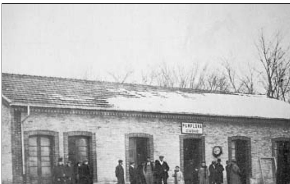
Estación del Plazaola junto a la carretera de Zaragoza, hoy avenida de Zaragoza, hacia 1918 (PCB)
